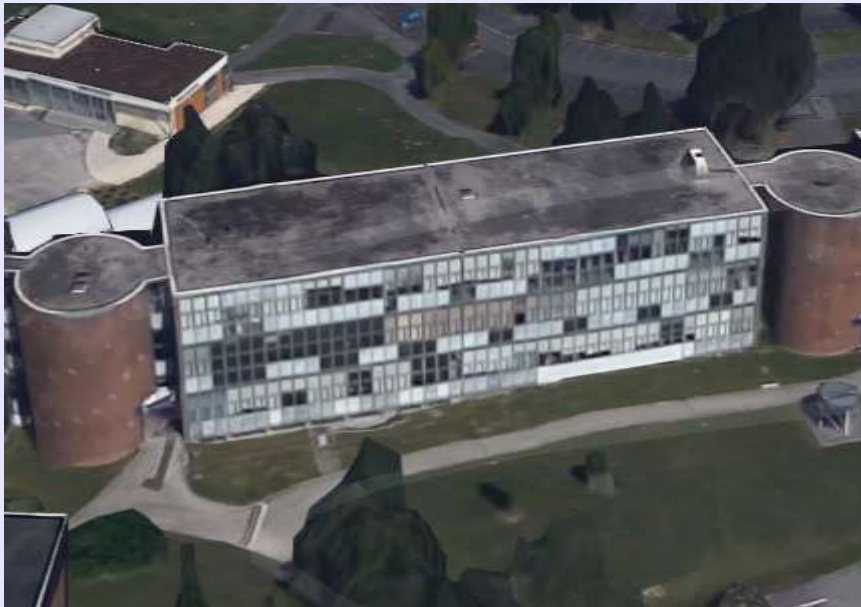
Faisabilité du solaire sur toiture
