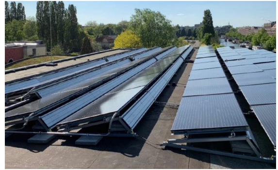
Het Palet en voorbeeld installatie PVT-panelen [Bron: IPA-id Rapport Palet (concept nov '20)]
